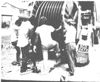
Kerja-kerja pemasangan kabel talikom oleh pekerja-pekerja Syarikat Talikom Malaysia.
